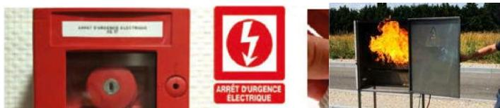
*L'extinction d'un feu électrique se fait par coupure de l'électricité
